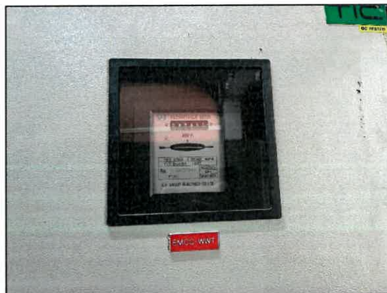
รูปที่ 3-43 มิเตอร์ไฟฟ้าสำหรับระบบบำบัดน้ำเสียโดยเฉพาะแยกจากระบบไฟฟ้าอื่นๆ
